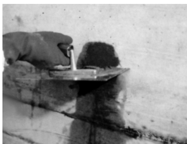
Po dostatočnom zatvrdnutí sa nadbytočný materiál odstráni.
