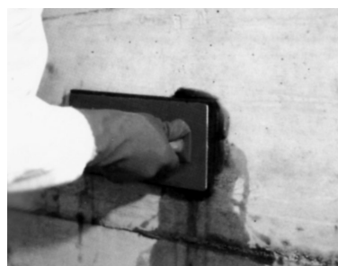
Na mieste výveru vody sa zatlačí a podrží na cca 30 sec.
